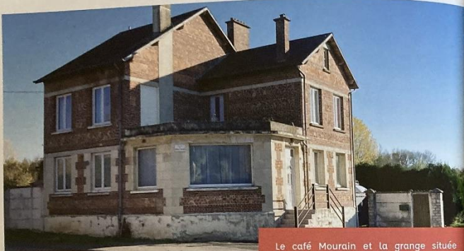
Canton de Marle (Aisne) - TAVAUX-PONTSÉRICOURT -
